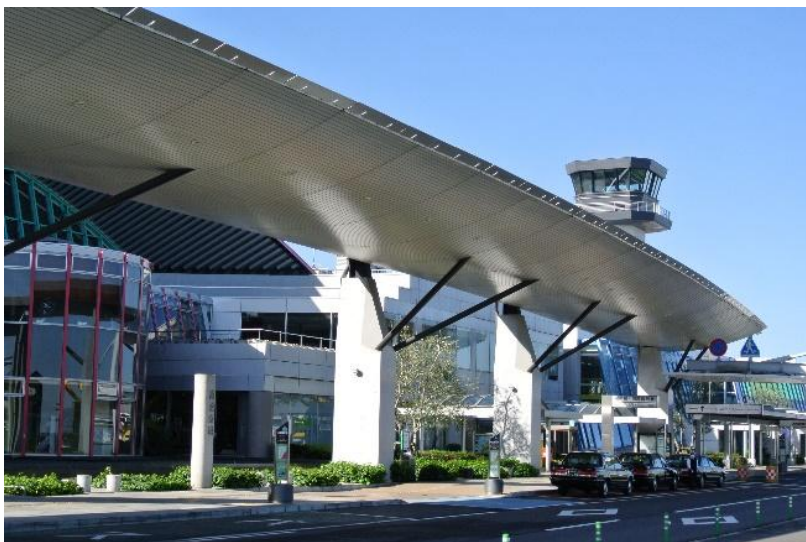
高松空港 外観
